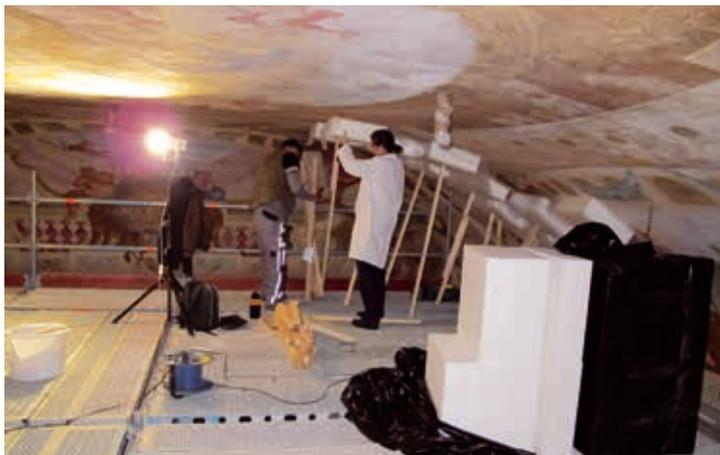
**Abb. 2: Schloss Lustheim, Deckengemälde im Festsaal: Sicherung der Deckenmalerei vor Arbeiten an der Gewölbekonstruktion.**
